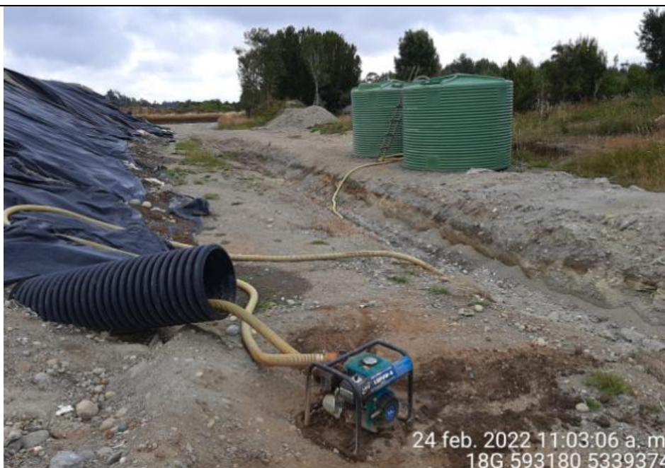
Fotografía N°10: Retiro de Lixiviados desde diagonal D02. Tomada: Jueves 24 de Febrero del 2022.
