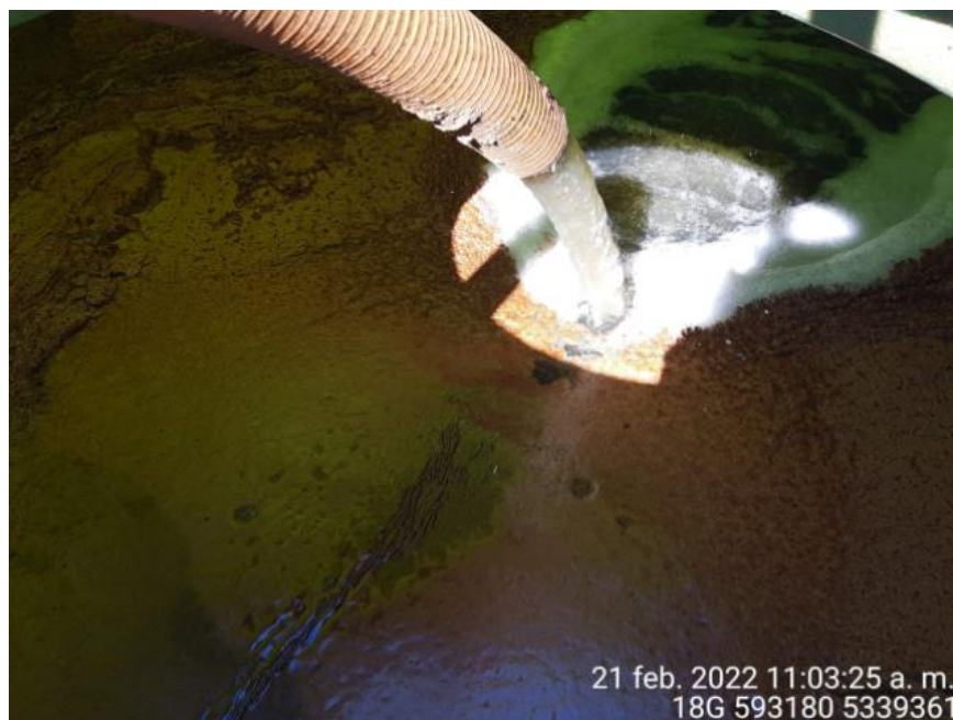
Fotografía N°2: Extracción de Lixiviados a estanque de acumulación. Tomada: Lunes 21 de Febrero del 2022.
