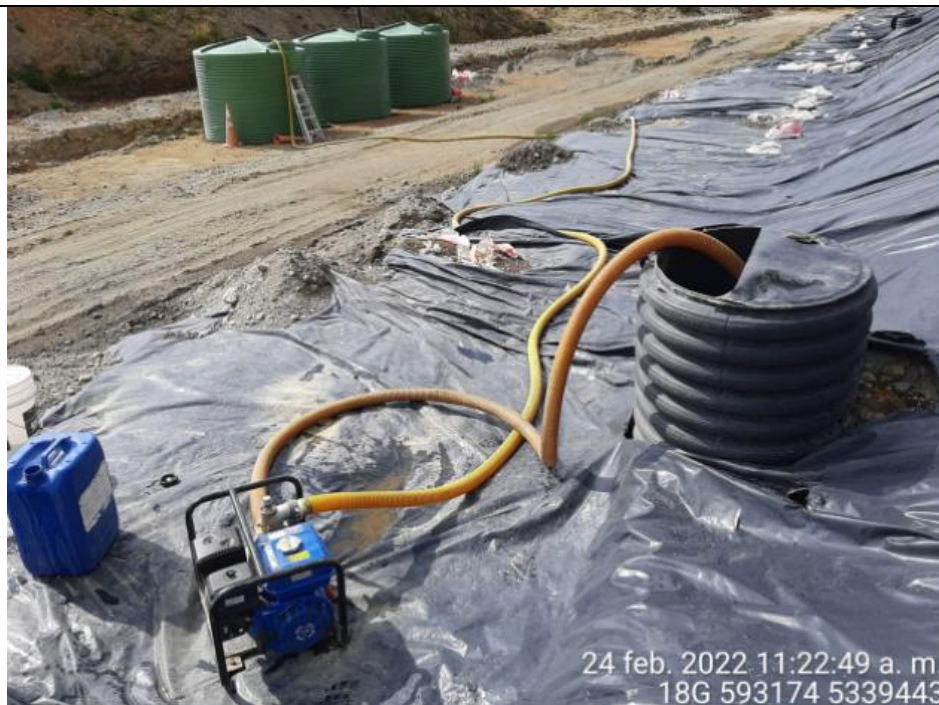
Fotografía N°9: Retiro de Lixiviados desde cámara C12. Tomada: Jueves 24 de Febrero del 2022
