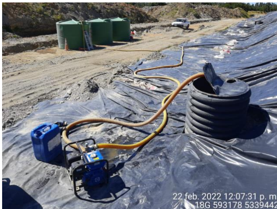
Fotografía N°3: Extracción de Lixiviados desde cámara C12 por personal municipal. Tomada: Martes 22 de Febrero del 2022.
