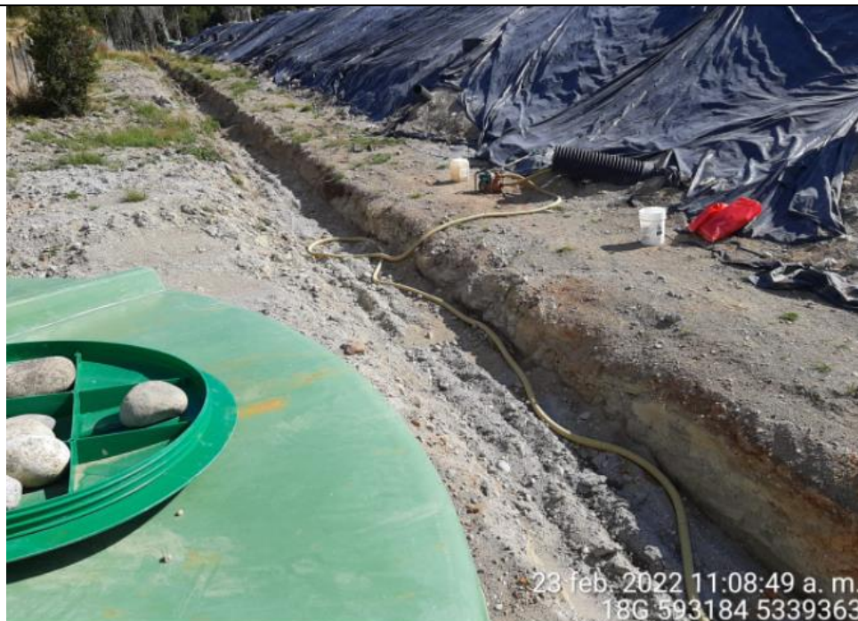
Fotografía N°7: Retiro de Lixiviados desde diagonal D02. Tomada: Miércoles 23 de Febrero del 2022.
