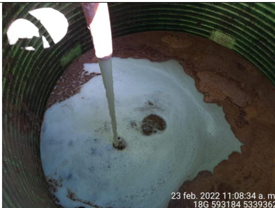
Fotografía N°8: Retiro de Lixiviados a estanque por personal municipal. Tomada: Miércoles 23 de Febrero del 2022.
