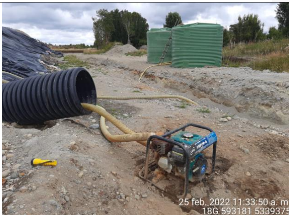
Fotografía N°12: Extracción de Lixiviados desde diagonal D02 por personal municipal. Tomada: Viernes 25 de Febrero del 2022.
