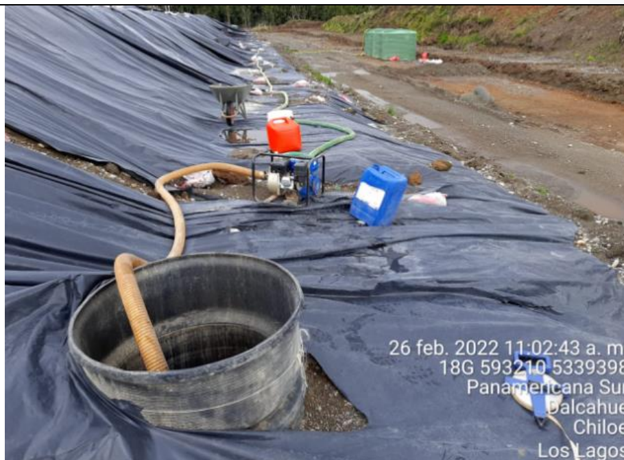
Fotografía N°14: Extracción de Lixiviados desde cámara C14 por personal municipal. Tomada: Sábado 26 de Febrero del 2022.
