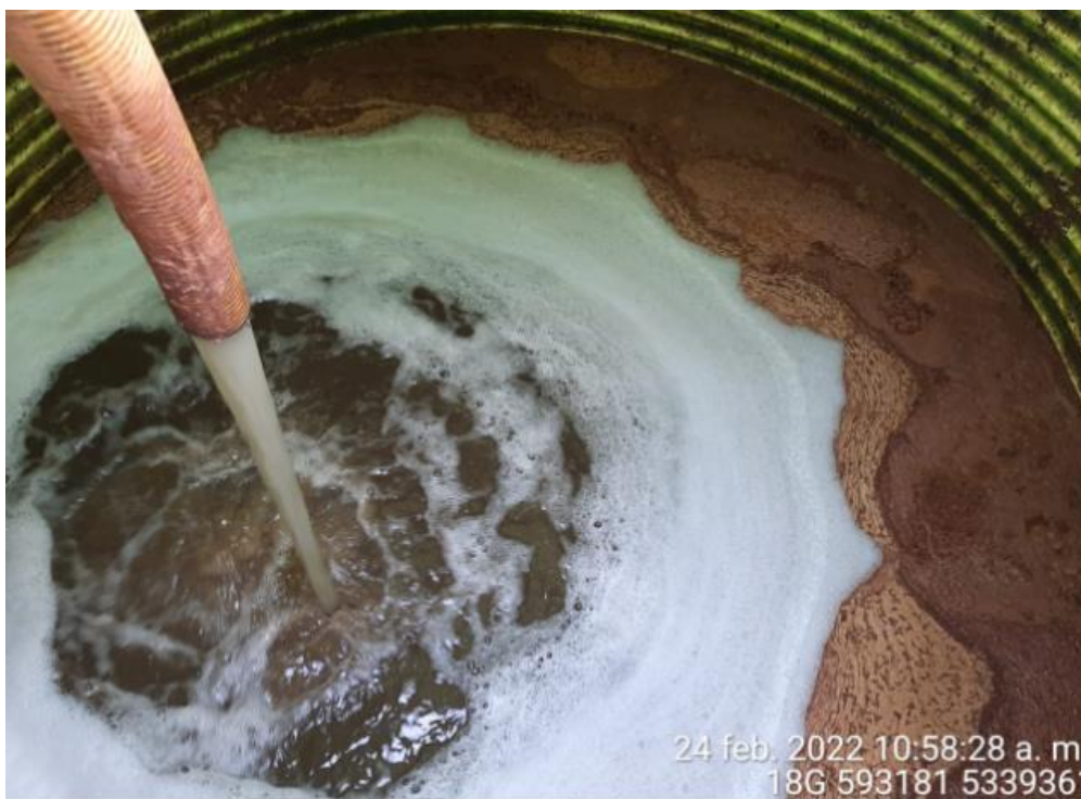
Fotografía N°11: Retiro de Lixiviados a estanque por personal municipal. Tomada: Jueves 24 de Febrero del 2022.
